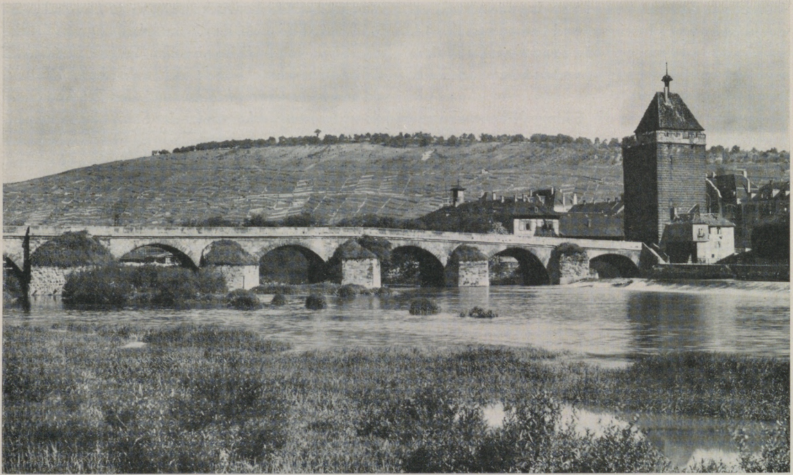
3. Eßlingen, Pliensaubrücke mit Torturm vom Oberwasser vor dem Umbau von 1927 Aufnahme Landesbildstelle Württemberg
