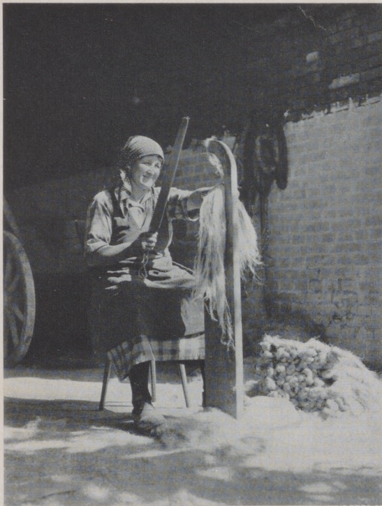
3. Schwingen am Schwingstock mit dem Schwingmesser
