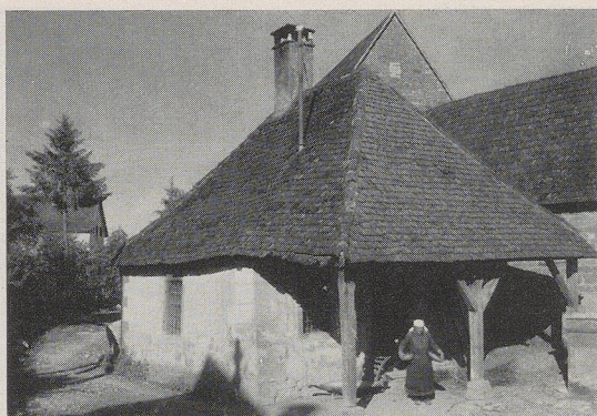
27. Pleidelsheim, schönes altes Backhaus Aufnahme Landesbildstelle Württemberg
