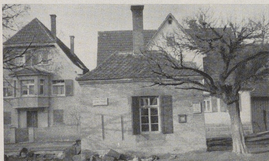
28. Endersbach, schlechtes Backhaus
