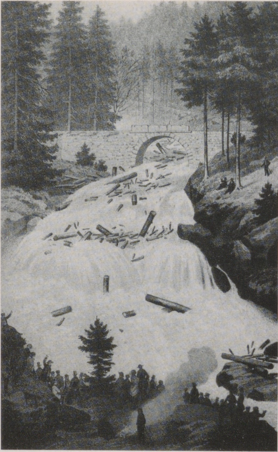
7. Schwallung für Scheiterholzflößerei im oberen Murgtal (nach Verwaltungsbericht 1896/97)
