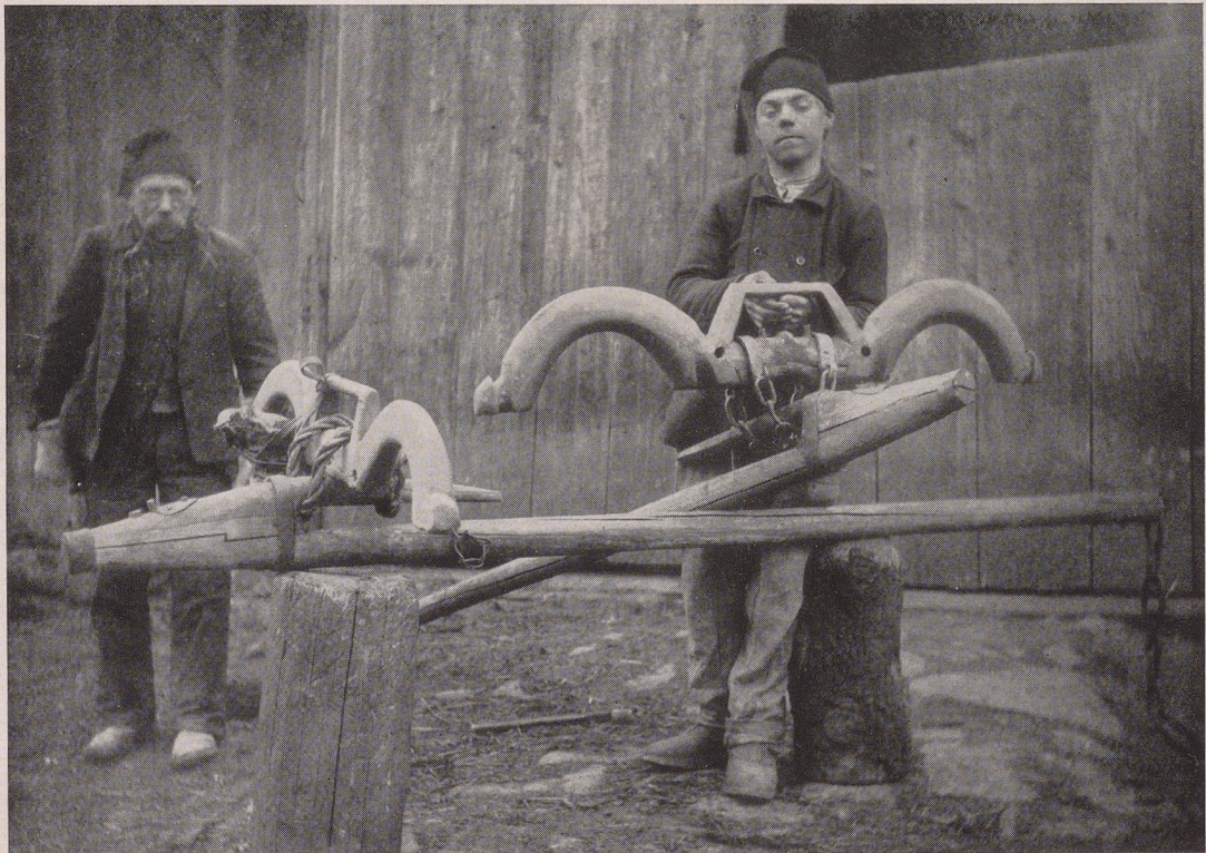
5. „Ganzes Joch“, Zugstange und beider Verbindung. Welzheimer Wald (Breitenfürst). Links: Ganzes Joch an der „Zaugel“ befestigt, der holzgeflochtenen A(n)blense. Rechts: Ganzes Joch verbunden mit der „Zaugel“ durch zwei eiserne A(n)blense-trümmer; um 1910
