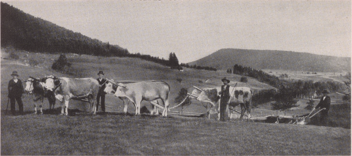
1. Pflügen am Fohrenbühl ob Schramberg; das erste Ochsenpaar vor dem Wendpflug zieht mit „Gabelzieher“, die zwei vorderen im „Zieher“, alle drei Paare im Doppeljoch; aufgen. um 1930
