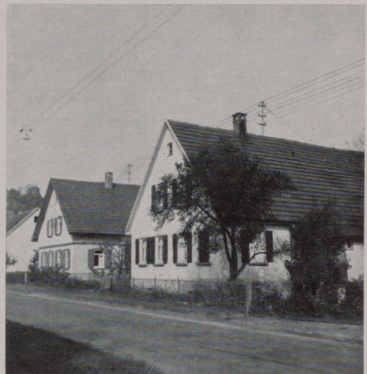
Häuser als Träger elektrischer Leitungen. Holzmasten hinter den Häusern würden nicht auffallen
