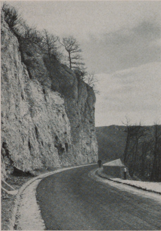
3. Neue Unterlenninger Steige: Kammfelsen und Stützmauer
