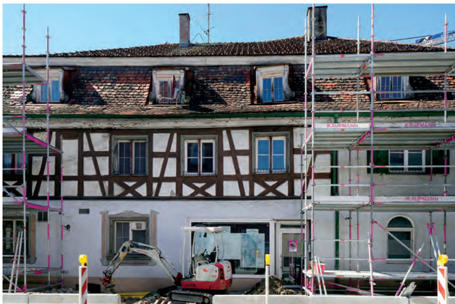
Das Fachwerk auf der Ostseite des Gebäudes, das mittels der Einrüstung auf seinen genauen Zustand untersucht werden konnte.
