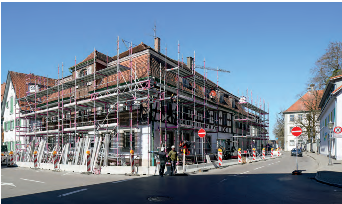
Der »Löwen« mit der aufwendigen Gerüstkonstruktion, die nicht im Fachwerk und den Gefachen verankert werden konnte, und zudem gegen den Straßenverkehr geschützt werden musste.
