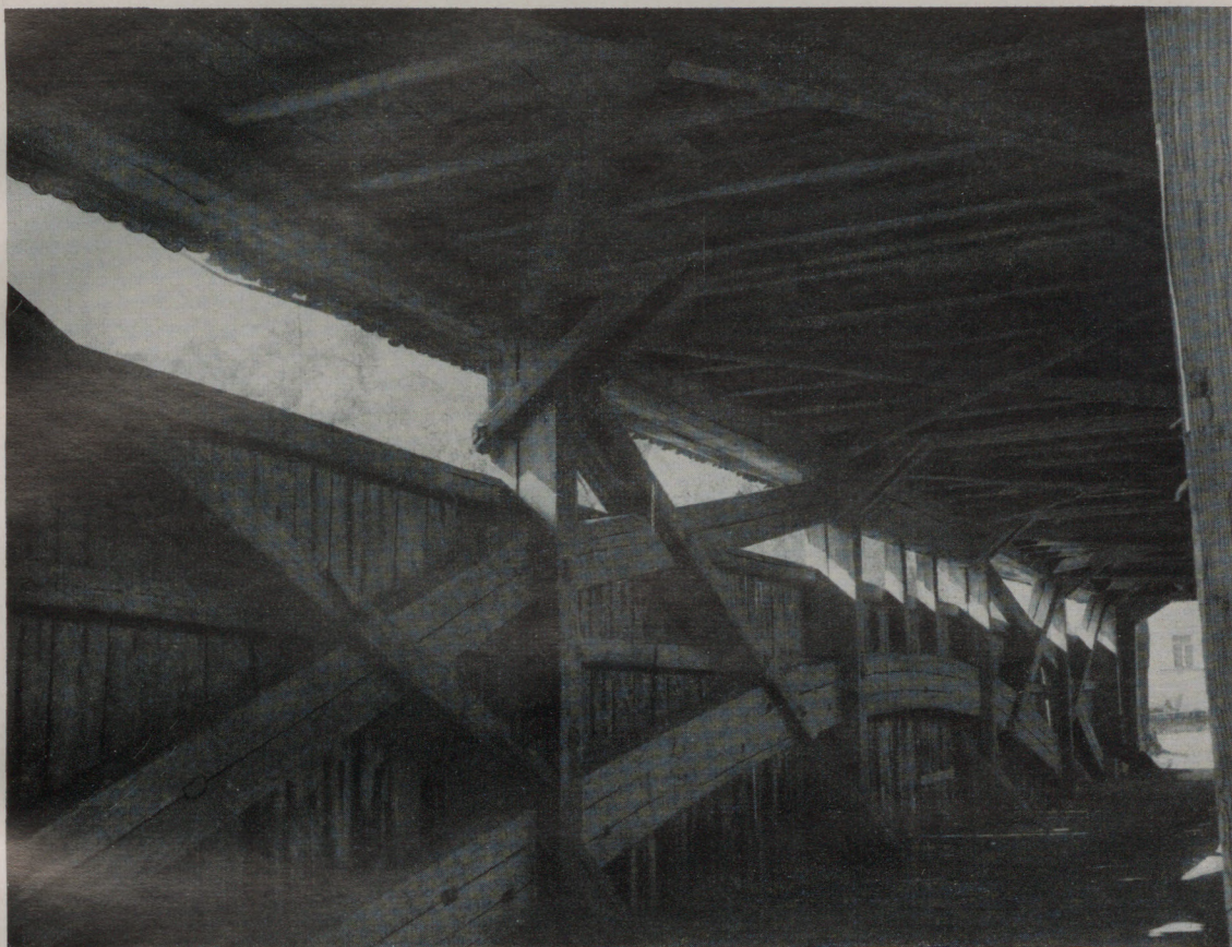
1. Die Rippergbrücke, eine Fahrbrücke von 1835. Mit der Lichtführung wird ein virtuoscs Spiel getrieben: 4 Meter hoch liegende, niedrige Fensterbänder bewirken einen fast sakralen Eindruck. Der Formenreichtum durch kreuz- und quergestellte Hölzer ergibt sich allein aus technischen Überlegungen. Ein großer Holzbogen ist die Grundlage der Konstruktion.
