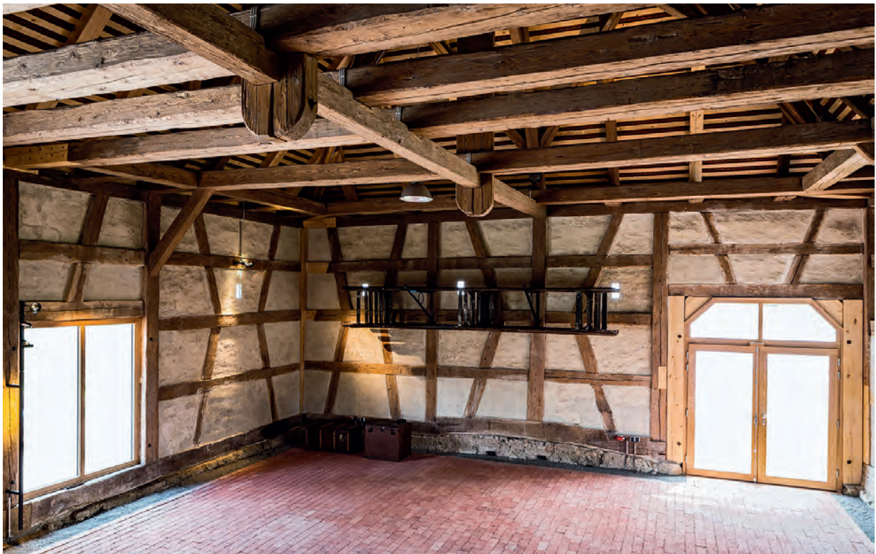
Respekt vor der Baugeschichte: Durch den behutsamen Verzicht auf einen Ausbau blieb der großartige Raumeindruck im ausladenden Inneren des Torkels für die weitere Nutzung des Gebäudes als Atelier erhalten.
