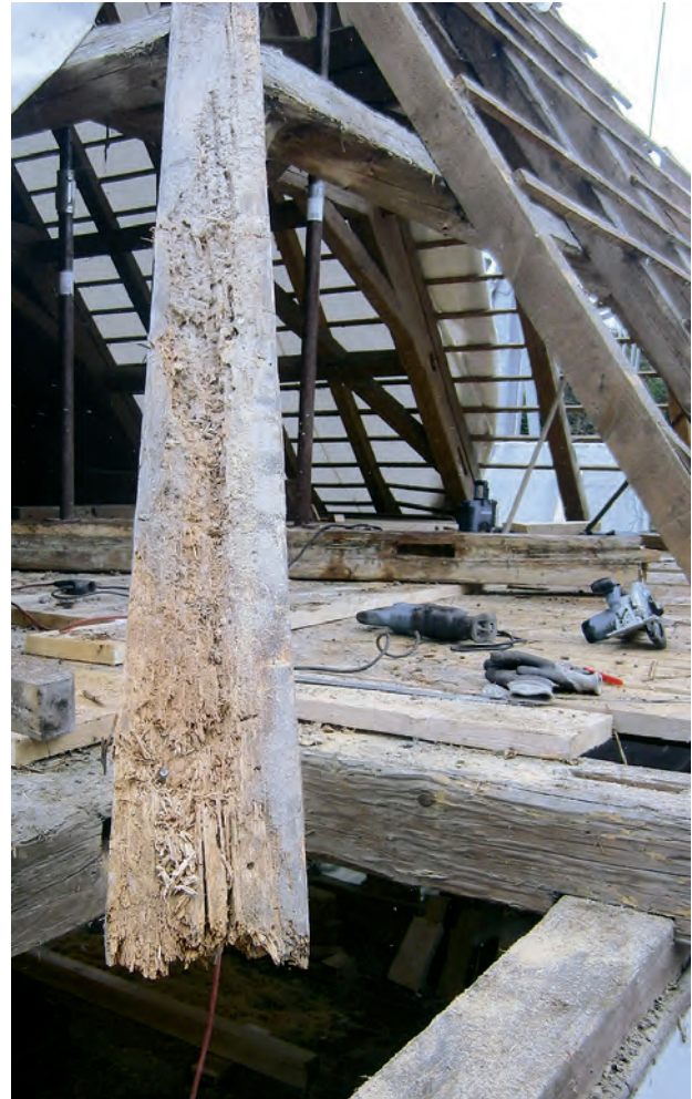
Auch hier waren gravierende Schäden zu beseitigen. Eine Aufnahme während der Sanierung.
