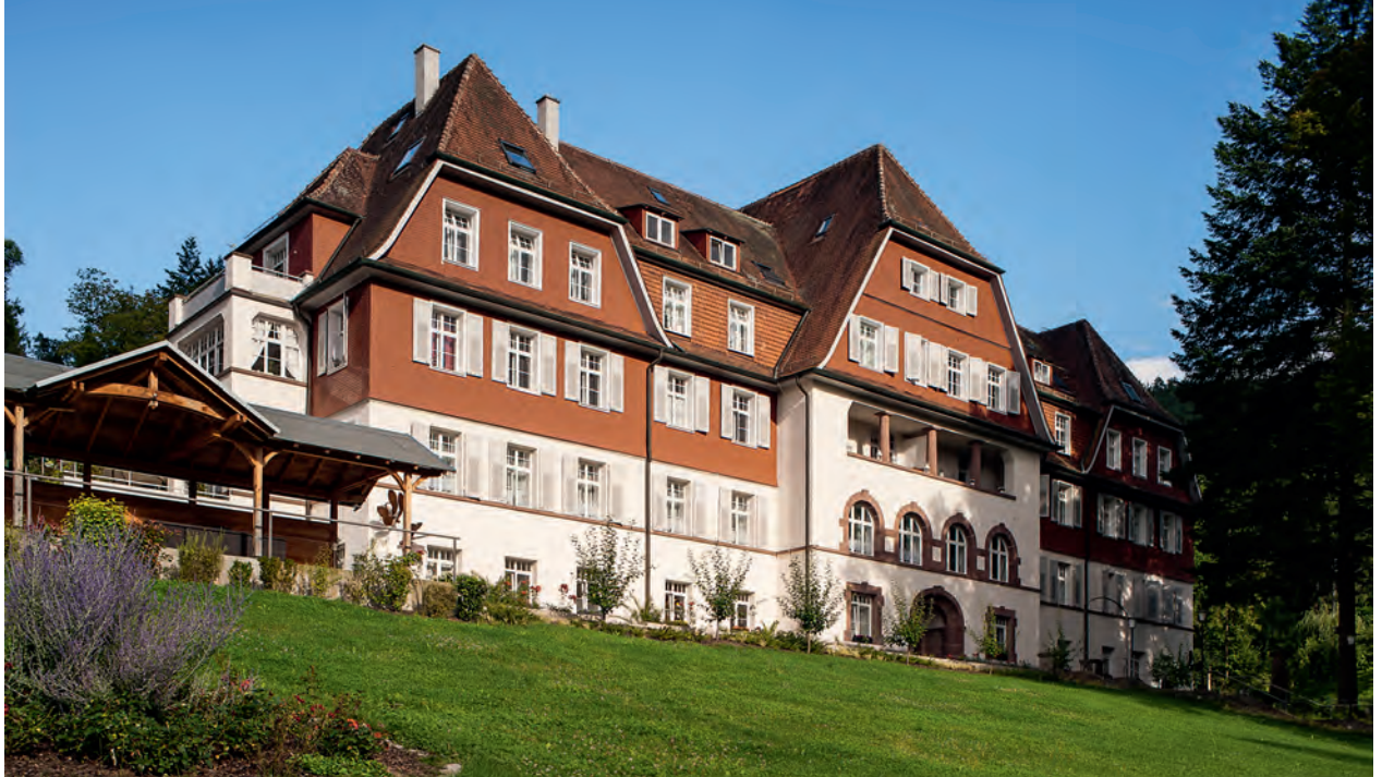
Tief heruntergezogene Dächer und die Teilverschindelung lassen das ehemalige Erholungsheim in Bad Liebenzell kleiner erscheinen als es tatsächlich ist. Nichts verrät außen die Umnutzung in Wohnungen.
