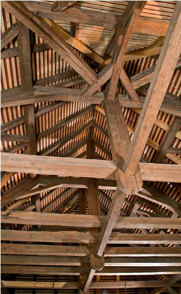
Der Blick in das Dachwerk zeigt die Qualität der Zimmermannsarbeit des 18. Jahrhunderts.
