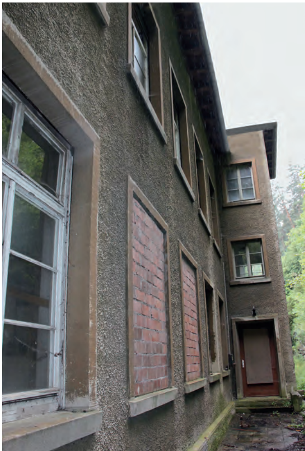
Heute ahnt niemand mehr, wie heruntergekommen das Gebäude vor der Sanierung war.
