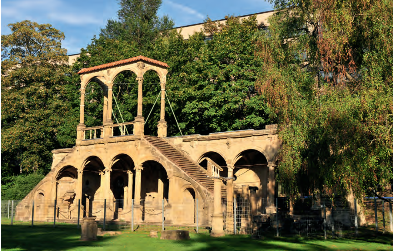
Über den doppelten Treppenaufgang erfolgte einst die Erschließung des im Obergeschoss befindlichen Festsaals. Auf den ehemaligen Arkadenumgang verweisen heute nur noch wenige Segmentbögen.
