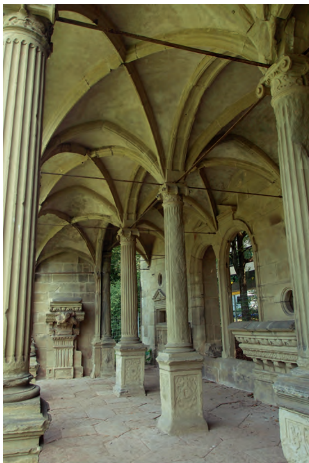
Die erhaltene Gewölbekammer unterhalb der Freitreppe lässt Einflüsse der Gotik, etwa in der Ausformung von Kreuzgratgewölben, deutlich erkennen. Postamente und Säulen hingegen zeigen bereits den Formenreichtum der Renaissance.
