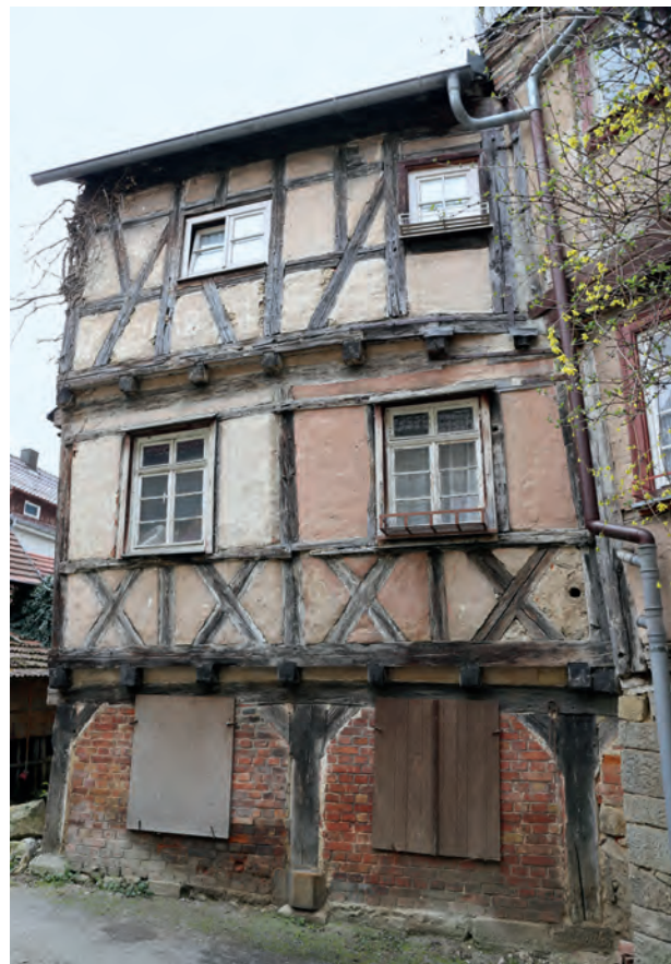
Markgröningen, Schlossgasse 2, Hinterhaus der Zeit um 1700/20. Die Hölzer der Außenwände sind fast alle geflößt, wie zahlreiche Wiedlöcher bezeugen.
