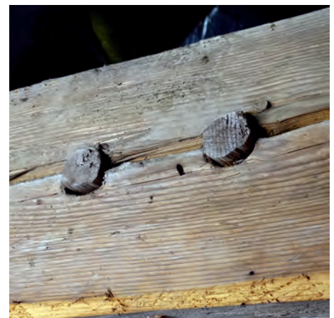
Bild links: Wiedlöcher am Ende einer Strebe im Dachwerk der Stadtkirche in Vaihingen/Enz (1697–1701). Mitte: Geflößte Eiche mit Wiedloch im mittelalterlichen Turm der Stadtkirche Bönningheim. Bild rechts: Bohrlochpaar mit abgeschlagenen Resten der Holznägel an einem Kehlbalken in dendrochronologisch auf 1544 datierten Dachwerk von Schloss Großsachsenheim.
