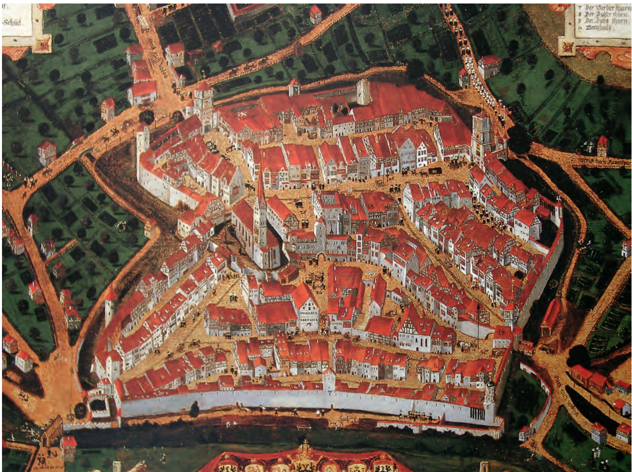
Die Wangener Stadtansicht von Andreas Rauch 1611 gibt Auskunft über die bauliche Gestaltung der Gebäude vor dem 30-jährigen Krieg.
