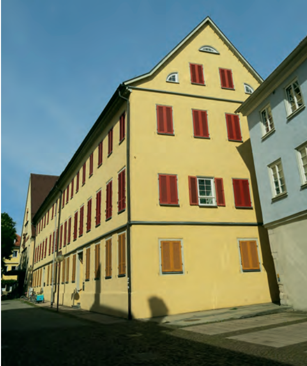
Gebäude des ehemaligen Franziskanerklosters am Blarerplatz in Esslingen, belegt nach Umbau von 1811 bis 1844 durch das Lehrerseminar und von 1844 bis 1877 durch die Knabenrealschule.
