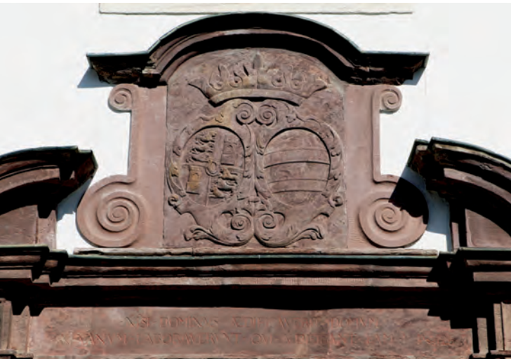
Über dem Portal finden sich die Wappen des Schlosserbauers Karl Heinrich Keller von Schleithem und seiner Gemahlin Anna Franziska Victoria Carolina Freiin von Gemmingen.
