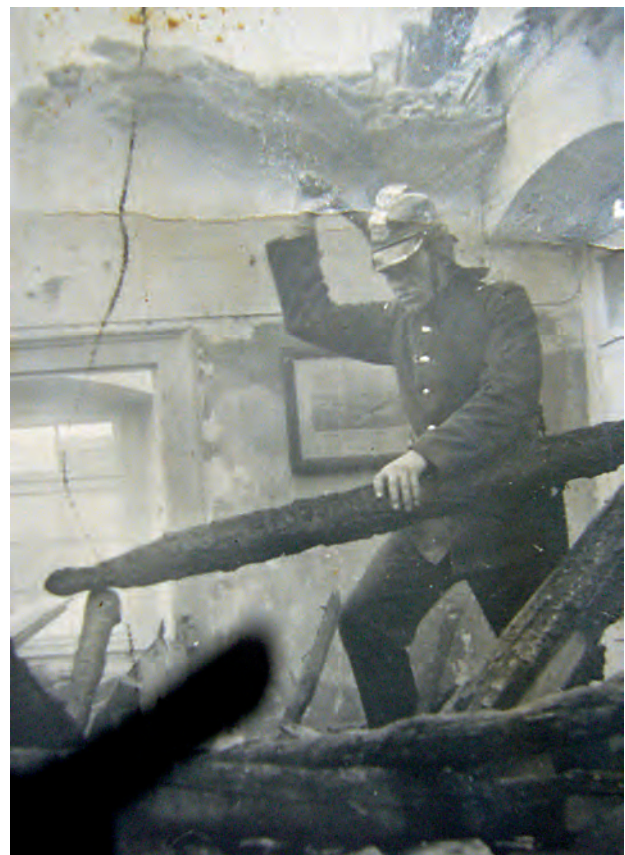
Das Feuer hatte sich rasch durch Decken und hohle Wände gefressen und ließ marodes Balkenwerk zurück.
