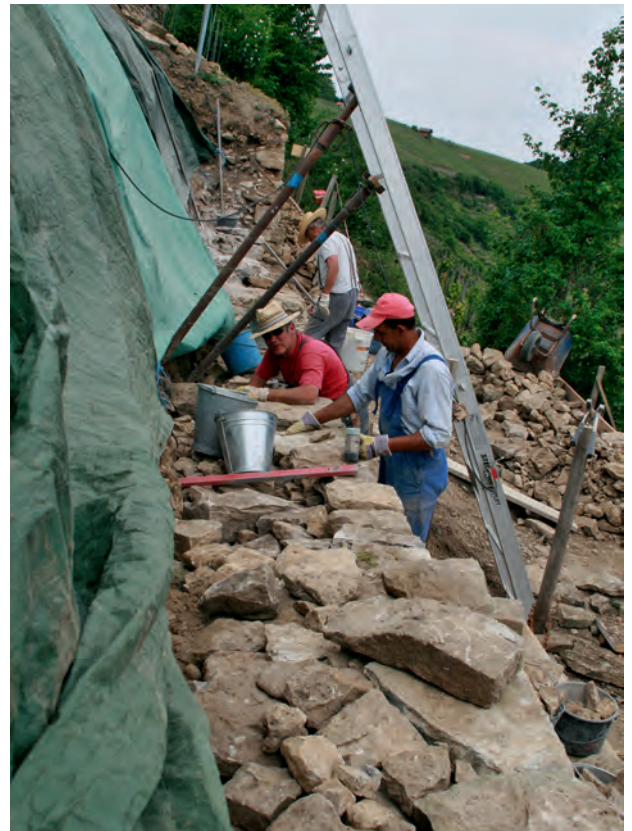
35 km Trockenmauern aus Muschelkalk instand zu halten, ist eine Daueraufgabe für die Roßwager Weinbauern und neben der Arbeit mit hohen Kosten verbunden.
