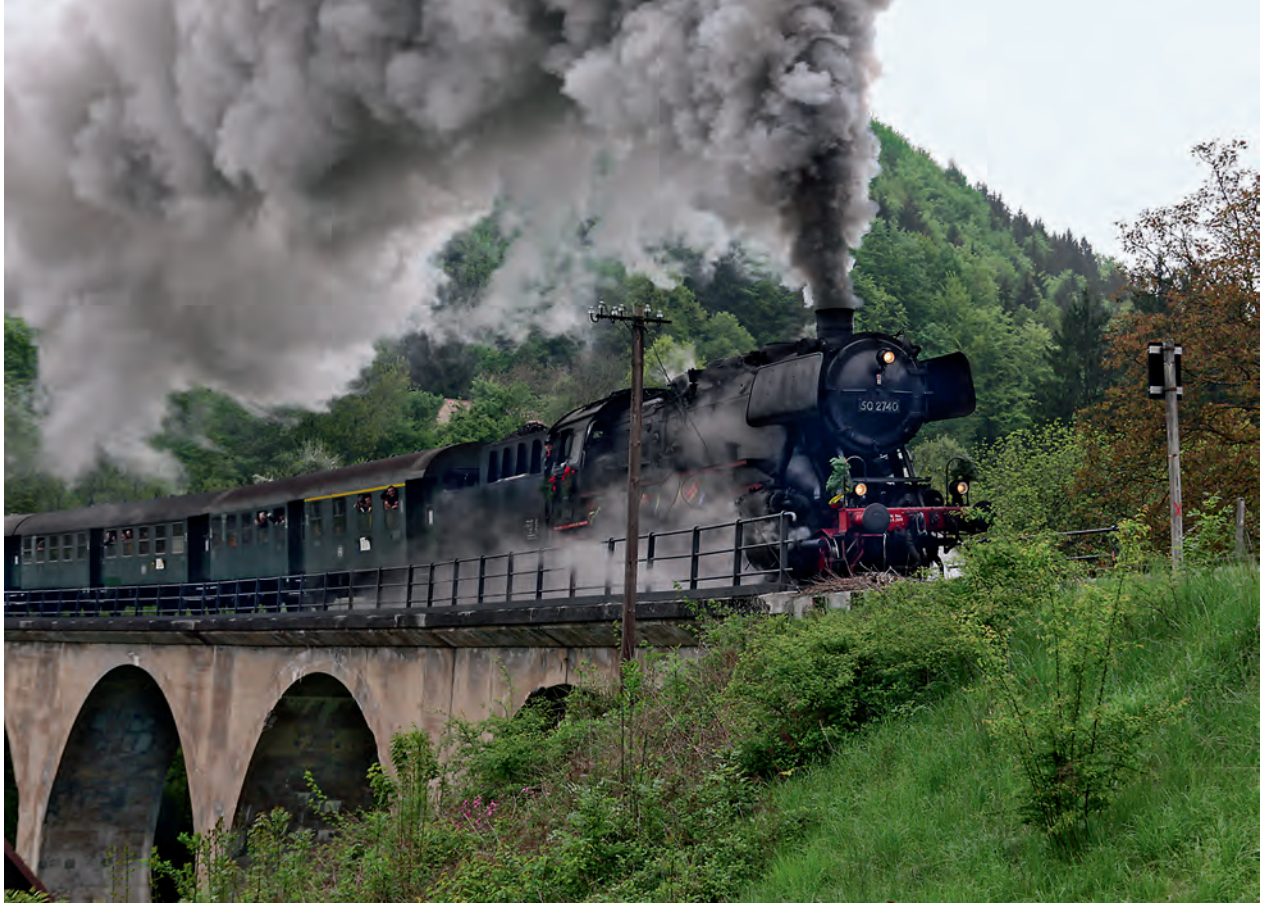
Der Bergbahncharakter wird besonders deutlich beim Strümpfelbach-Viadukt.
