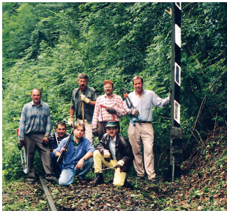
Oben: So sah die Bahntrasse zu Beginn der Streckenarbeiten fast überall aus.
