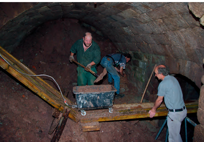
Mit Hilfe einer pfiffigen Spezialkonstruktion konnte die Erde aus dem teilverfüllten Eiskeller nach draußen geschafft werden.
