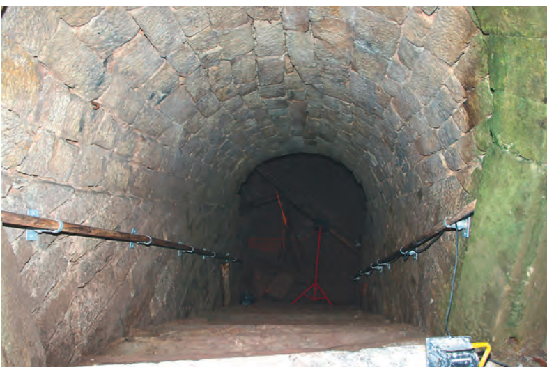
Steil hinab führt die Treppe zwischen den beiden Keller-geschossen, – auch sie war voller Schutt und Müll gewesen.
