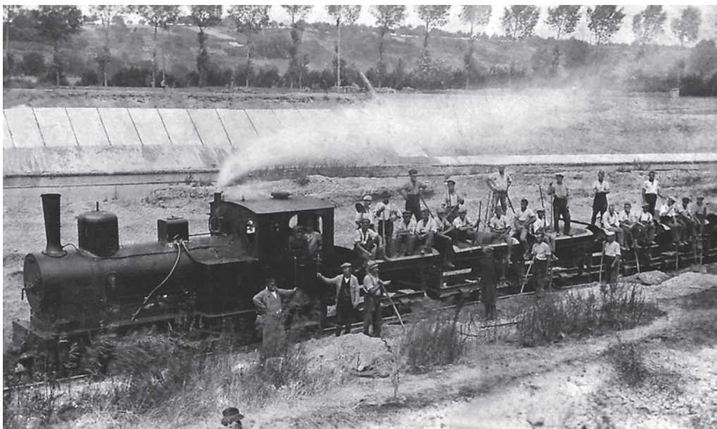
Arbeiter beim Ausschachten des Kanalbetts 1928 bei Heilbronn-Horkheim.
