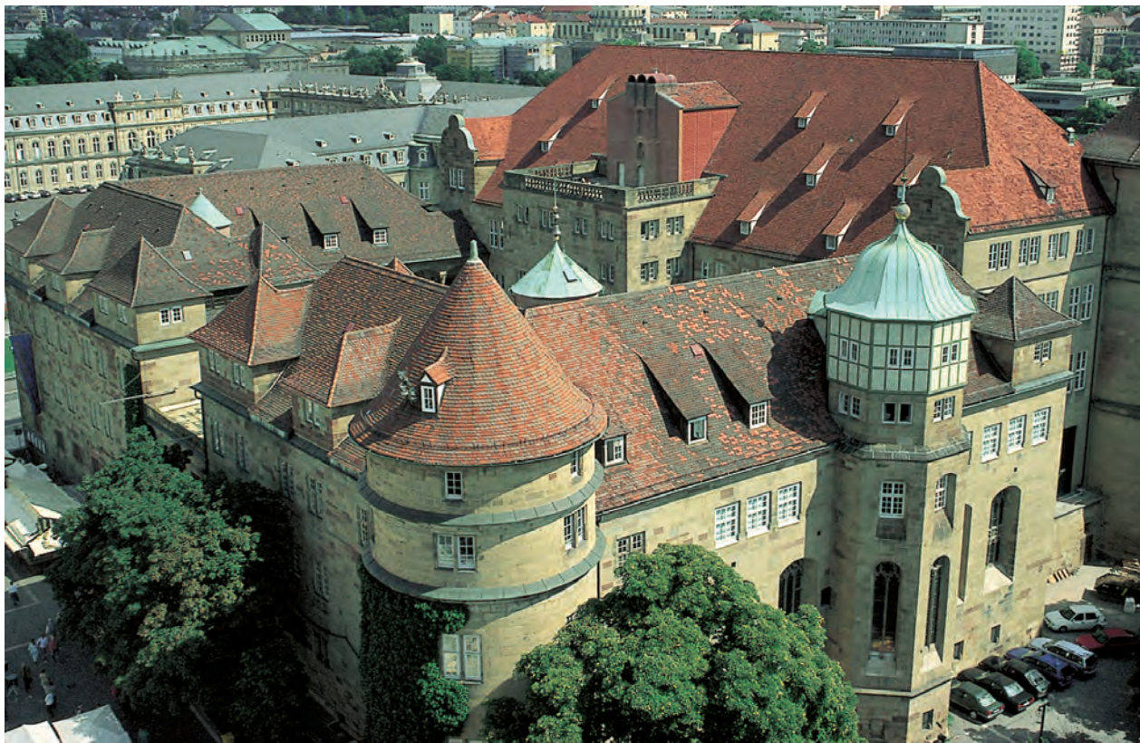
Altes Schloss in Stuttgart. Schlosskirche, Chor in der Mitte der südlichen Längswand.
