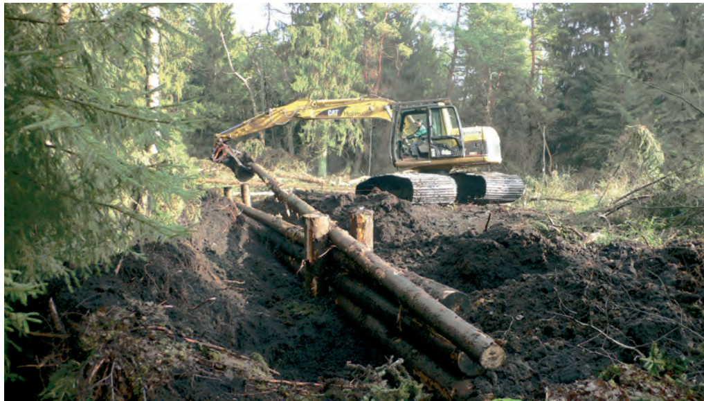
Palisaden aus Fichtenstämmen erhöhen die Standfestigkeit von Torfdämmen an größeren Entwässerungsgräben.
