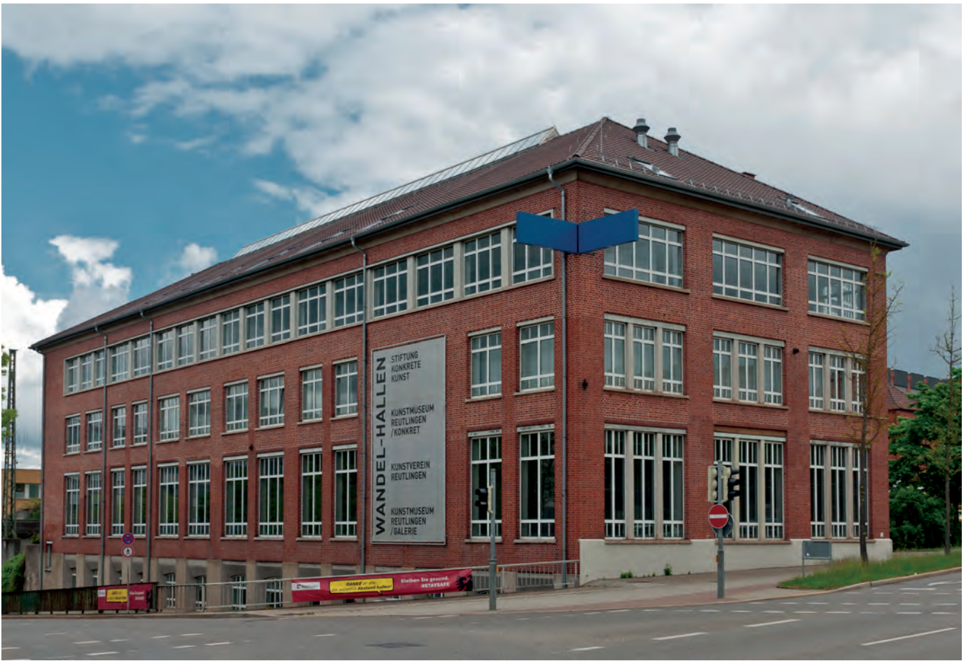
Früher Sitz der Metalltuch- und Maschinenfabrik Christian Wandel, sind die Wandel-Hallen heute ein Ort der Kunst.
