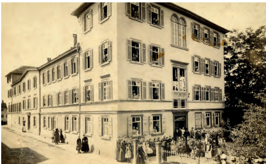
1921 gründete Hoffmann die »Töchteranstalt« zunächst in einer bestehenden Kelter nördlich des Saalplatzes. Sie musste dann einem Neubau weichen, der ein Schülerinnenwohnheim sowie eine höhere Mädchenschule beherbergte. Wegen des schlechten Baugrunds aus Gipskeuper wurde das Gebäude in den 50er-Jahren abgebrochen. Das Foto zeigt das Töchterinstitut um 1896.
