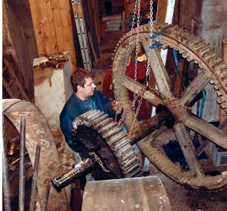
Viele Teile der Waldachtaler Mönchhofmühle mussten grundlegend überholt und saniert werden.
