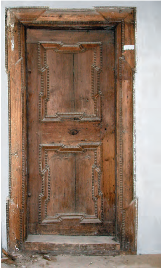
Türöffnung des zweiten Obergeschosses mit aufgedoppelter Kassettierung und Profilleisten an Türblatt und Rahmung während der Restaurierung.
