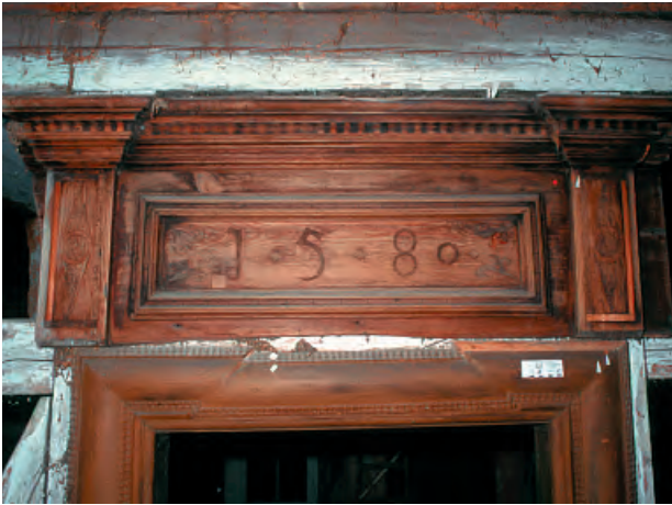
Über der Küchentür des zweiten Obergeschosses angebrachte Holztafel mit Intarsienarbeiten und der Jahreszahl 1580. Sie gehörte einst mit einer Türrahmung im ersten Obergeschoss zusammen.
