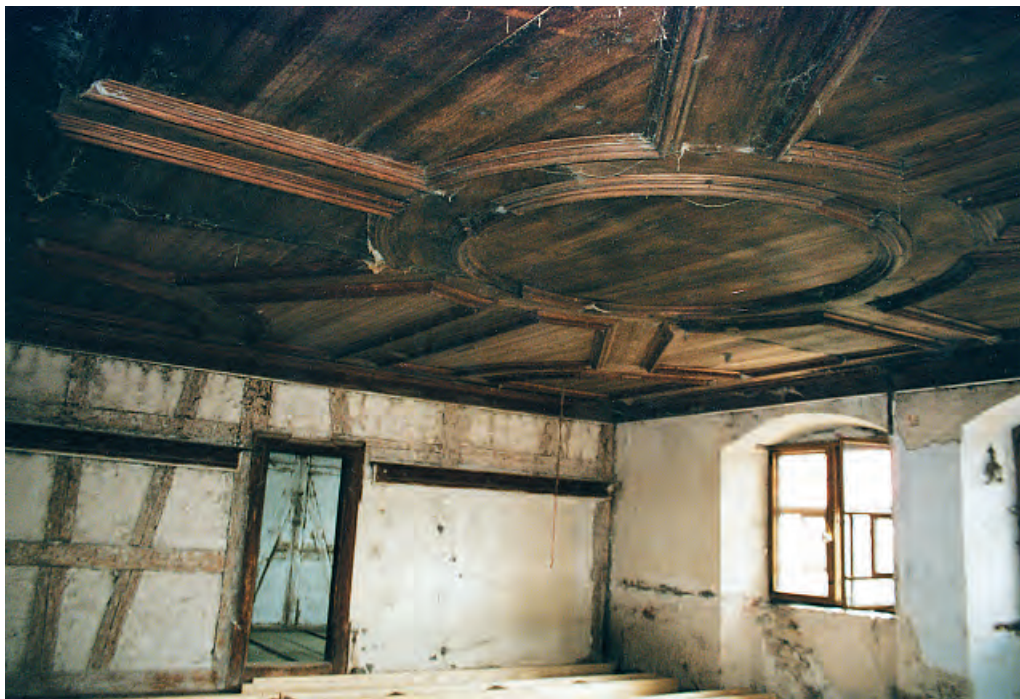
Der Saal im zweiten Obergeschoss mit seiner hölzernen Decke während der Restaurierungsarbeiten 2002.
