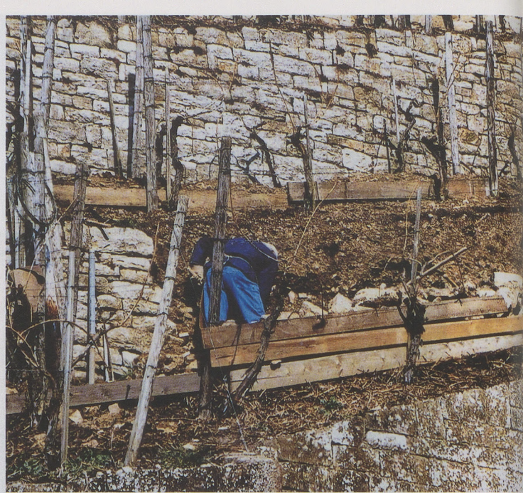
Die Mundelsheimer Wengerter wissen, was sie im Winter zu tun haben: Überall in den Rebhängen sind Trockenmauern zu erneuern.
