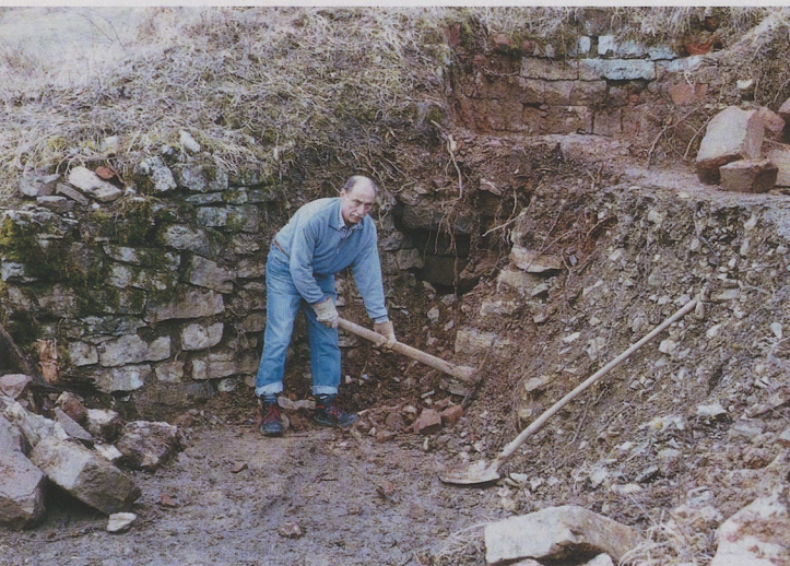
Hans Zweig – hier beim Bau von Trockenmauern – hat auch einen Kalkofen restauriert und überdacht (siehe oben).
