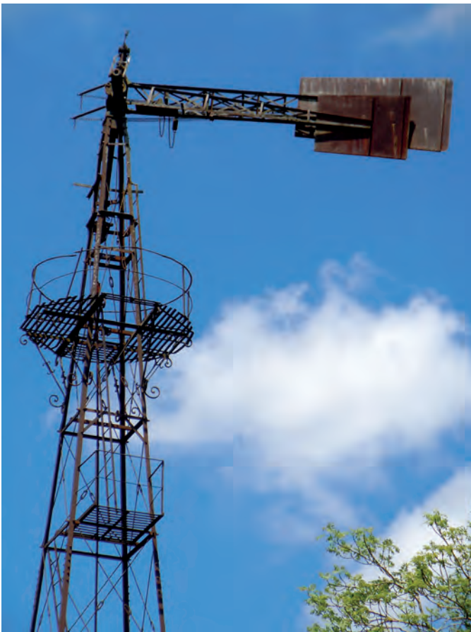
Filigrane Schmiedearbeiten an der Arbeitsplattform des »Patent Ultra«-Windrades von Talacker bei Bad Wurzach-Seibranz
