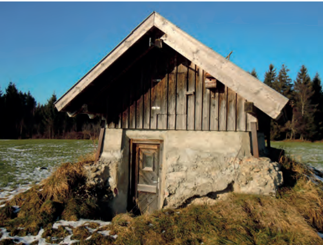
Überreste eines Gittermastes flankieren das Pumpenhäusle von Kifßlegg-Unterriedgarten.
