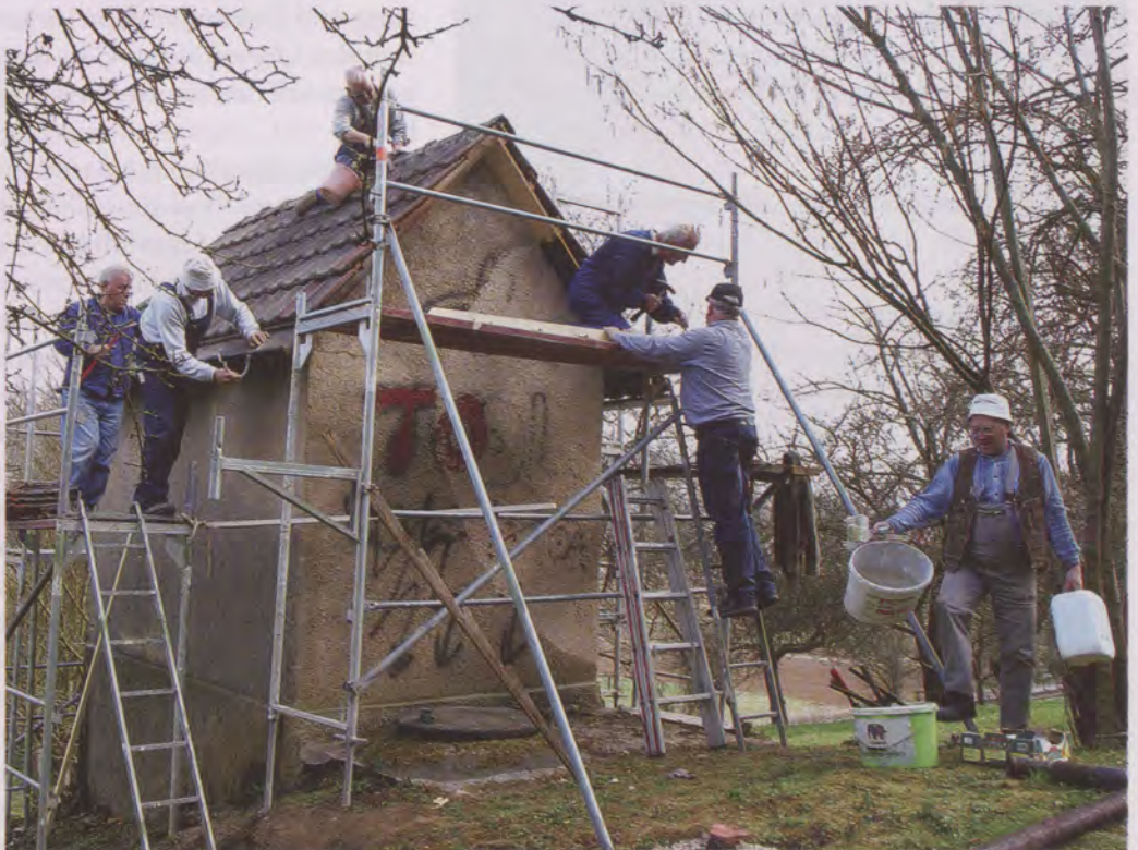
Die kellerartige Fassung der Weiherbrunnenquelle in Winterbach im Rems-tal wird seit drei Jahrzehnten nicht mehr genutzt. Mitglieder des Arbeitskreises Museum im örtlichen Heimatverein haben die ganze Anlage vor dem Zerfall bewahrt.
