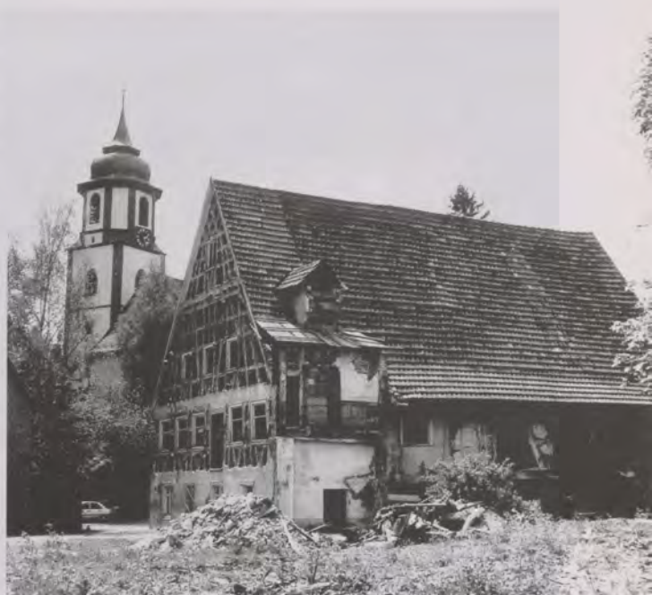
Zustand des Alten Schul- und Rathauses vor der Sanierung und kurz vor dem Abriss des östlichen Gebäudeteils.
