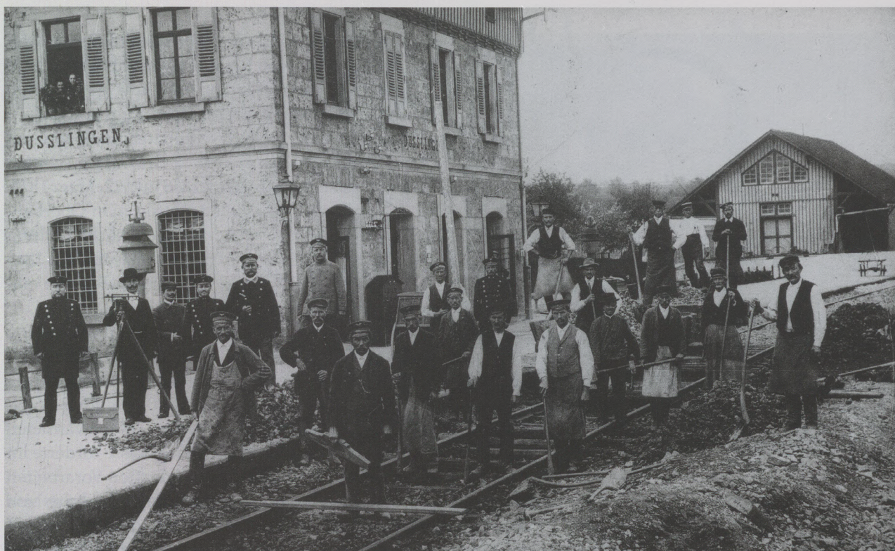
Der Eisenbahnbau war im 19. und noch lange im 20. Jahrhundert Handarbeit. Hier erneuert um das Jahr 1900 die Rotte der Bahnmeisterei Tübingen das Gleis 1 im Bahnhof Dusslingen.
