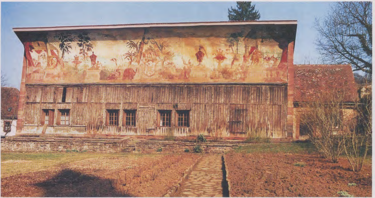
Die Orangerie im Kloster Bronnbach von Süden. Die Wege des Glashausgartens wurden vermutlich mit dem Bau der Talstraße im 19. Jahrhundert verändert. Am linken Bildrand das nahe gelegene Gasthaus, rechts der angebaute Stall.
