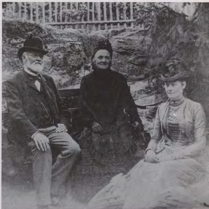
A. Beck, Bauinspektor beim Bau des Eisenbahnviaduktes. Aufnahme aus der Zeit vor 1900.
