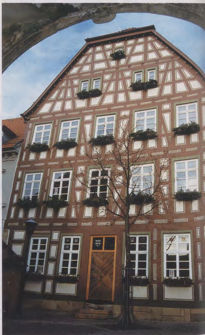
Das einst vom Einsturz bedrohte Gebäude ist mittlerweile der Stolz der Bürgerschaft: Der fertig sanierte Schweizer Hof in Bretten erstrahlt in neuem Glanz.
