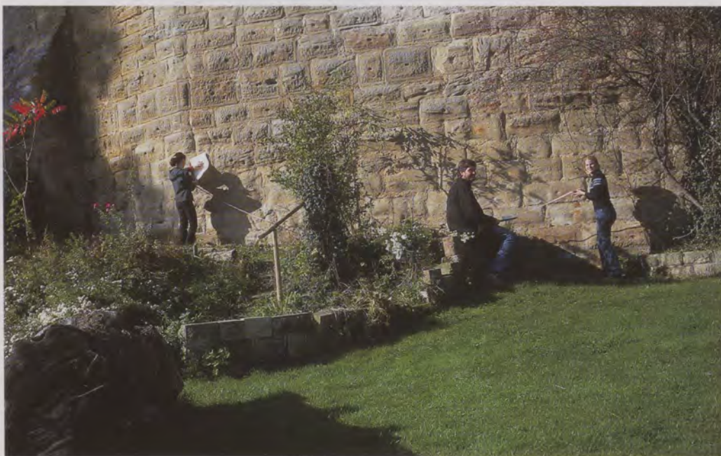
Die Mauer, die das Wäscherschloss umschließt, hat Generationen von Kunsthistorikern Rätsel aufgegeben. Kirchheimer Gymnasiasten vermessen das Mauerwerk genau.
