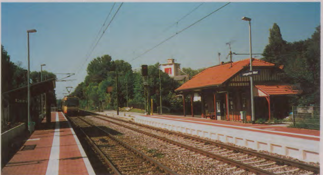
Der neue Stadtbahn-Haltepunkt Leingarten West, ehemals der Bahnhof Schluchtern.
