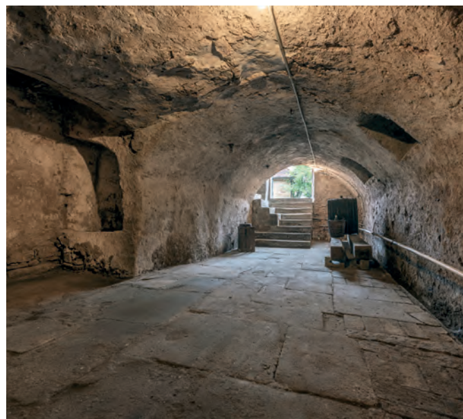
Hier war Platz für Fässer: der Gewölbekeller unter einem Teil des Gebäudes mit einem breiten Zugang von außen und einer internen Treppe in den Eingangsbereich
