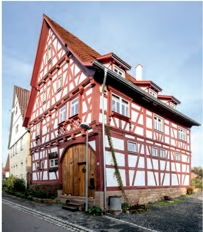
Oben ein Bild des Niedergangs: das Fachwerkhaus in Maulbronn-Zaisersweiher vor der Sanierung, heute ist es wieder ein Schmuckstück für den Ort.
