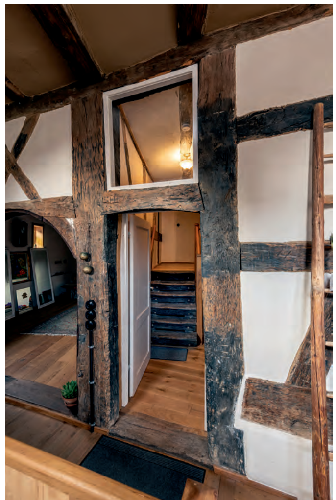
Blick von der ehemaligen Durchfahrt auf die Treppe
