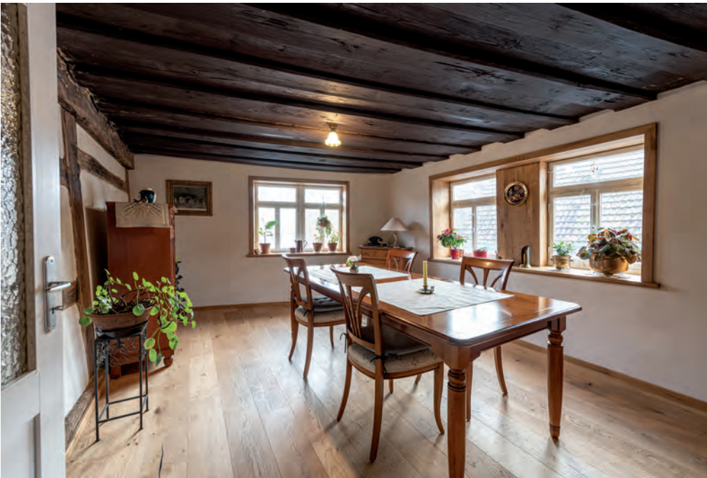
Die Stube im Obergeschoss mit alter Decke und reparierten Fenstern
