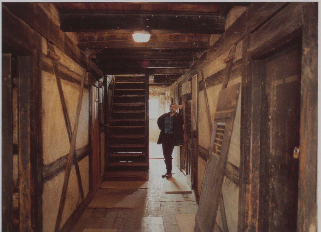
Das original erhaltene Dachgeschoss mit seinen ehemaligen Schlafkammern bleibt unausgebaut, um die denkmalpflegerisch wertvolle Bausubstanz erhalten zu können.
