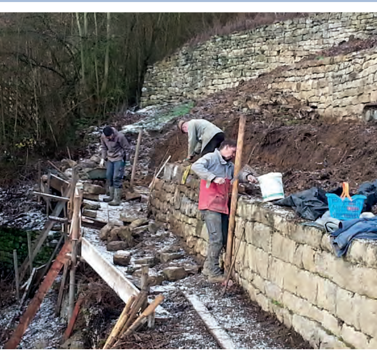
Mit schwerem Gerät, mühevoller Handarbeit und sehr viel Geschick hat Familie Velte etwa 150 m 2 Trockenmauern im „Schrannawengert“ erneuert oder umgestaltet.
