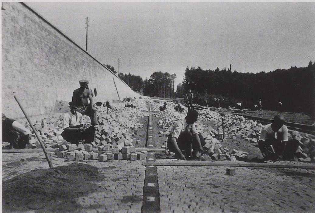
Pflasterung der Aufstiegsstraße unterhalb der Böschungsmauer bei Aichelberg im Jahre 1937.
