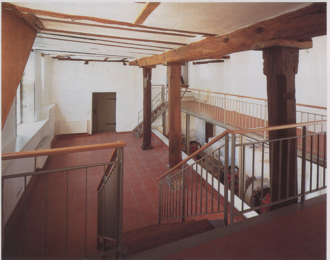
Der ehemalige Maschinenraum der Mühle mit den offenliegenden Transmissionen und dem ehemaligen Sackboden ist heute ein großzügiger Eingangsraum.
