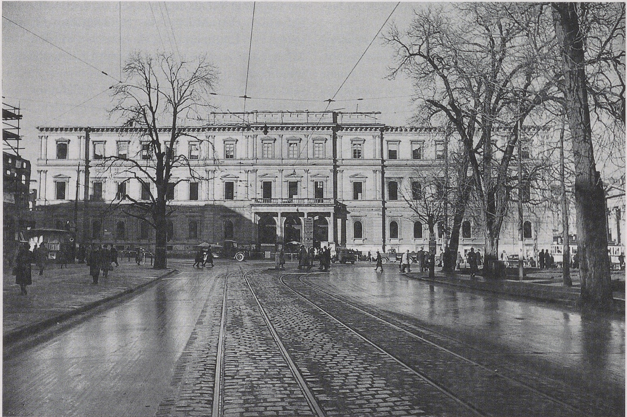
Die Ruine des Kronprinzenpalais im Januar 1949. Die Umfassungsmauern waren fast unversehrt. Der Abbruch dieses Bauwerks am Stuttgarter Schlossplatz verzögerte sich bis zum Frühjahr 1963.
