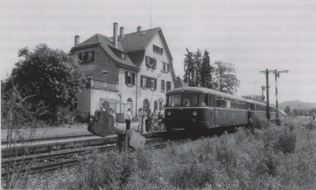
Der Tübinger Westbahnhof mit rotem Schienenbus und alter Signaltechnik. In Betrieb bis Mai 1999.
