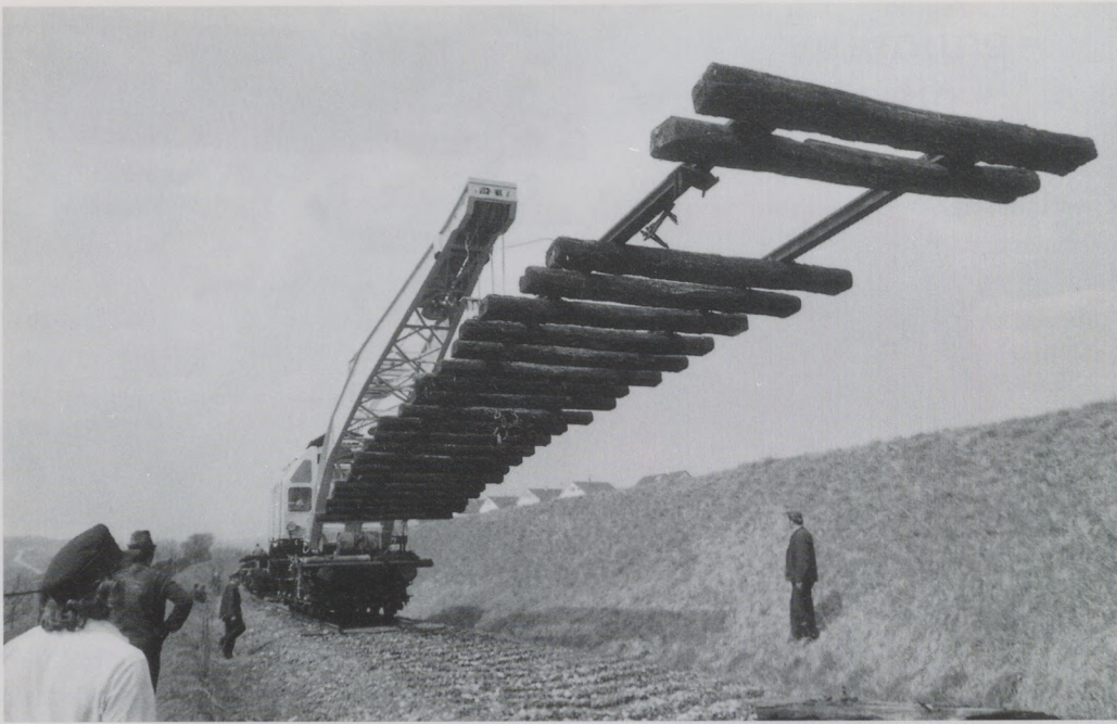
Um vollendete Tatsachen zu schaffen, läßt die Bundesbahn zwischen Herrenberg und Gültstein 1973 vier Kilometer Gleise abbauen.
