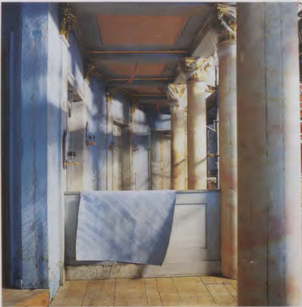
Maltechnische Restaurierung des ersten Rangs: Farbmuster.
