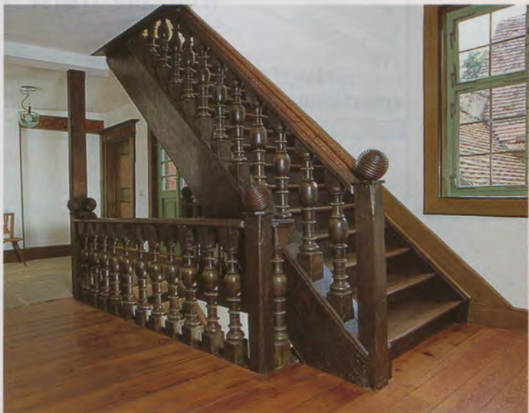
Treppenhaus mit barocker Holzterrappe und Baluster-Geländer.
