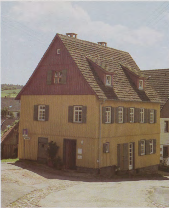
Das Bettelhaus in Ebhausen-Rotfelden.
