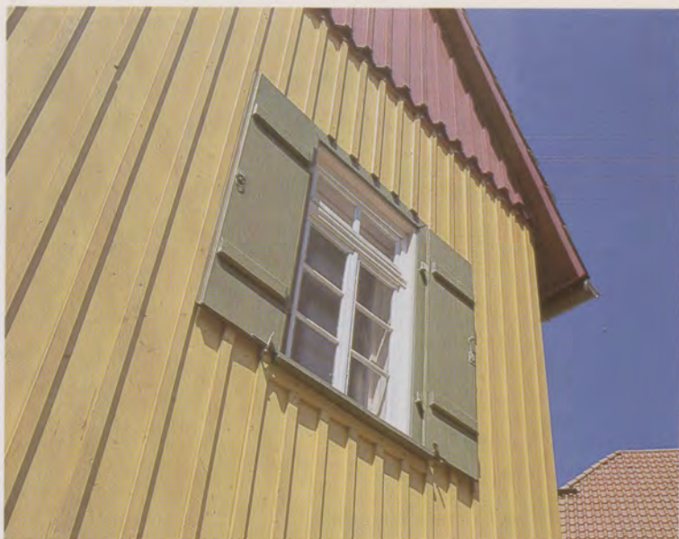
Außenansicht mit Sprossenfenster und Klappläden. Die Deckelschalung des Äußeren entspricht in Form und Farbigkeit dem historischen Zustand.
