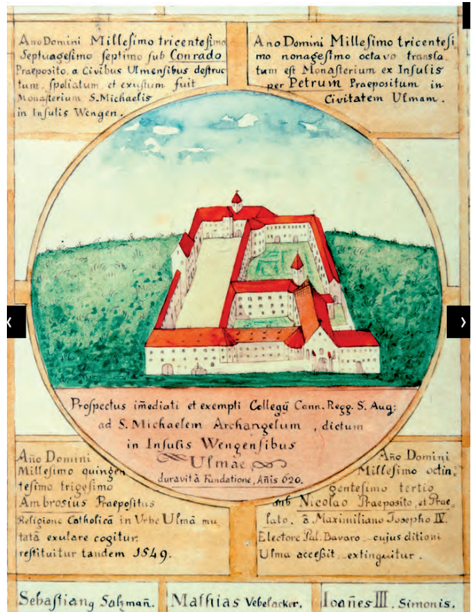
Diese Zeichnung entstand angesichts der Auflösung des Stifts im Jahr 1803 und spiegelt den letzten Bauzustand als geistliche Einrichtung dar.
