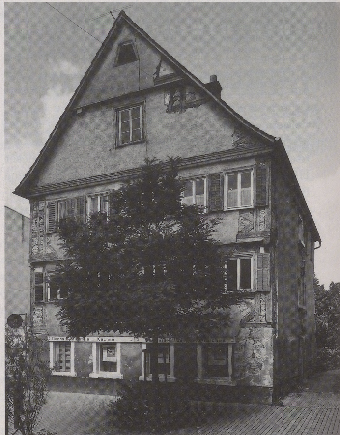
Erhalt «unzumutbar». Dieses dreigeschossige barocke Fachwerkhaus in Schwäbisch Gmünd wurde abgerissen.
