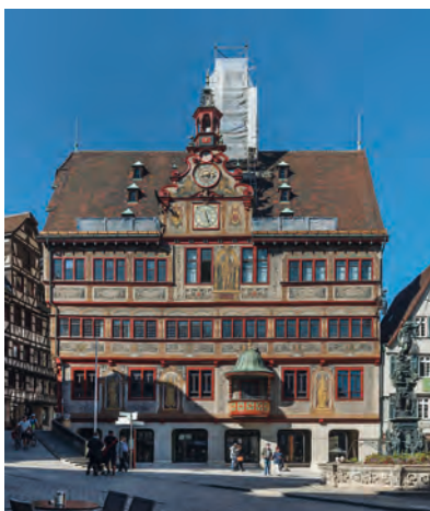
Das frisch renovierte Tübinger Rathaus (hier noch teilweise eingerüstet).
