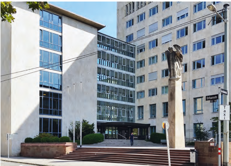
Das Stuttgarter Justizforum in der Urbanstrasse: hinten das Hochhaus mit dem Justitia-Relief, davor die Verfassungssäule, links das Landgerichtsgebäude und links von der Treppe die Inschrift von 1994 zum Gedenken an die Opfer der NS-Justiz.
