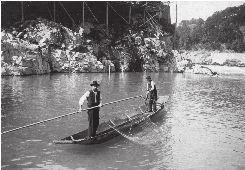
Der Fischer Adolf Rueb schaut uns an, in der Hand die Stange mit dem Fangnetz. Das Bild entstand wohl 1910 während der Bauarbeiten des Kraftwerks Laufenburg, als man in der «Enge» Felsen sprengte und Ufer befestigte.
