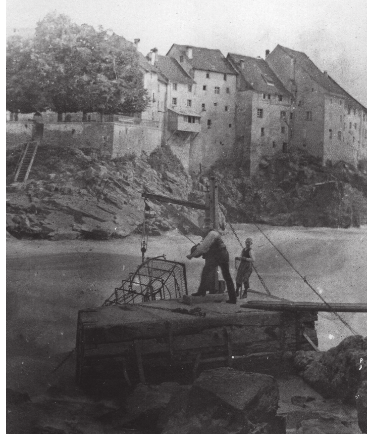
Fanganlagen für Salme der Fischerfamilie Rueb mit dem Kran für die mittlere und dann die Dreieckelreue. Die Bohlen ermöglichten den Zugang zu den Fangplätzen. Gerade wird eine geschmiedete Reuse hochgezogen.
