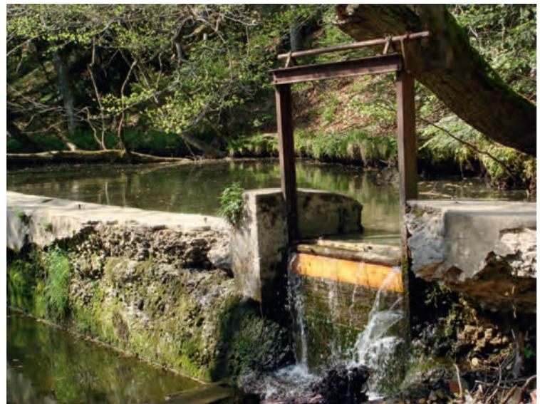
Über Wehre und Fallen wie in der Rot am Abzweig des Hammerschmiedekanals bei Liemersbach wurden oft mehrere unterschiedliche Räderwerke hintereinander angetrieben.
